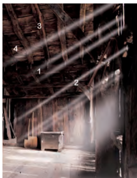
1 Gai-haga 2 Besoak 3 Kapirioak 4 Latak (Iturria: Igartubeiti: Gipuzkoako baserri bat. Argazkia: Xabi Otero)
